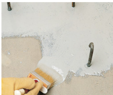
Aplicación de Eporip con brocha para puente de unión
