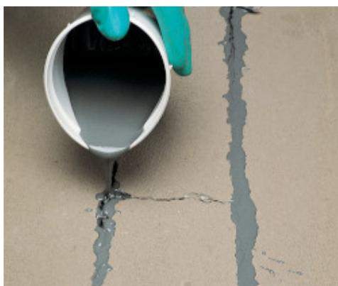
Reparación de grieta en recocado cementoso con Eporip
