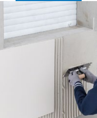
Instalación de baldosas con relieve acusado en el exterior
