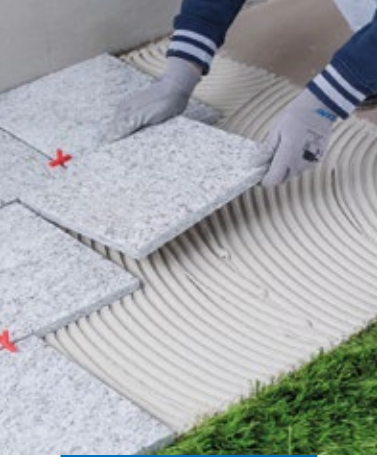
Colocación de gres en el exterior
