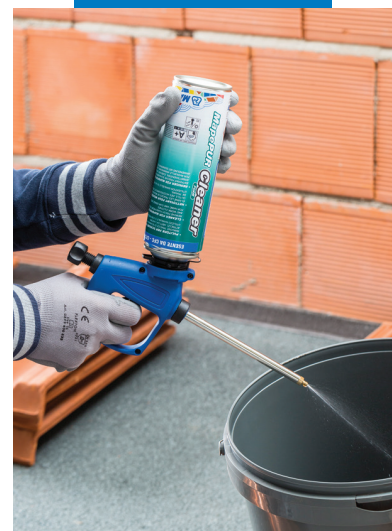
Limpieza de la pistola para espuma
